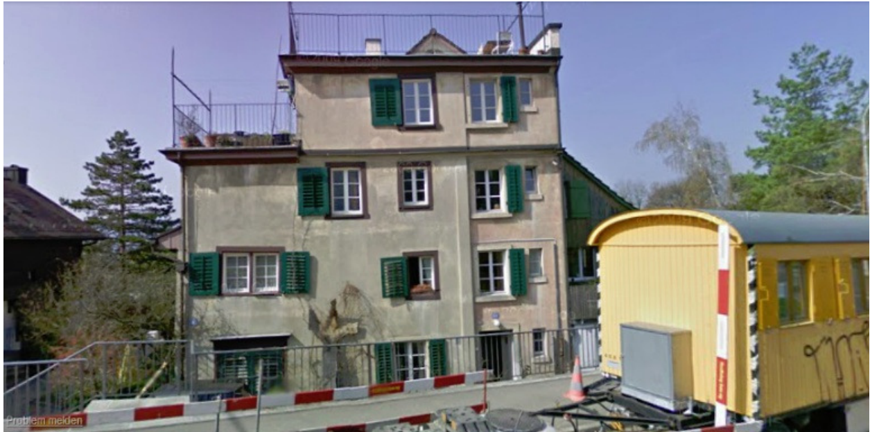
„Weggelassener Teil des Dachstocks“, Eierbrechtstr. 44, 8053 Zürich (google)
